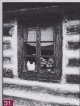
31 Les joints sont calfatés par un torchis
