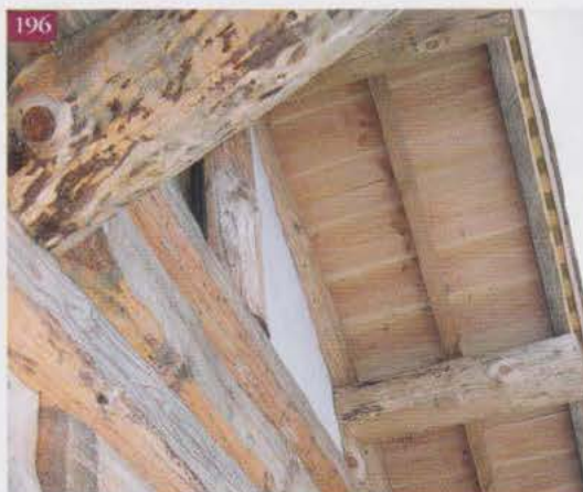
En Haute-Savoie : poteaux, bois « facés », charpente-poteaux, avec remplissage de vitrages et torchis de terre (Architecte : Camille Houdart, Ent. M. Fordy)
