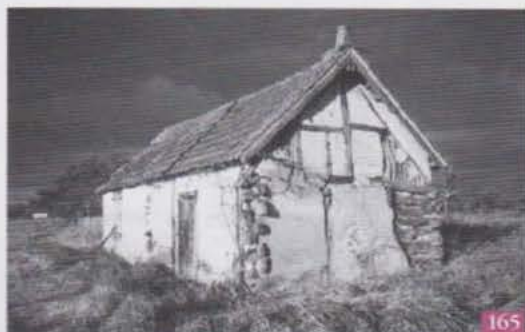
Cette maison de bûcherons de l'Allier (Thionne), a été, comme beaucoup d'autres, recouverte d'un torchis pour cacher les bois et renforcer l'isolation
