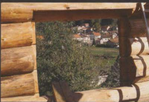
5. Espace de tassement et rainure d'encastrement ont été taillés avant remontage
