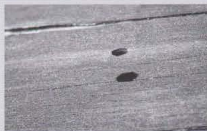
Trous de sortie du capricorne
