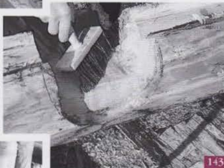
Application de sulfate de cuivre au pinceau large...
