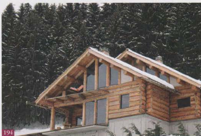
En Haute-Savoie : poteaux, bois « facés », charpente-poteaux, avec remplissage de vitrages et torchis de terre (Architecte : Camille Houdart, Ent. M. Fordy)
