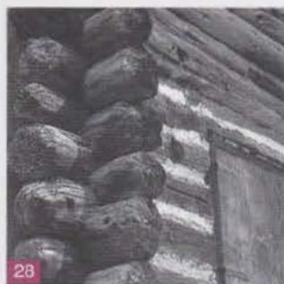
Détail d'un mur en bois empilé non jointés au Tyrol : la partie habitation a été calfatée de chaux
