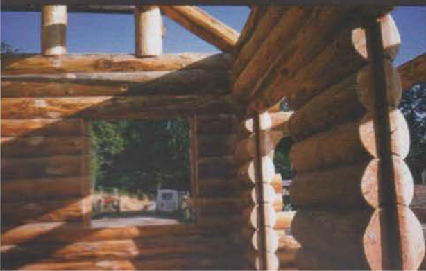
7. Toutes les rainures d'encastrement ont été faites avant le démontage. Charpente-poteaux.
