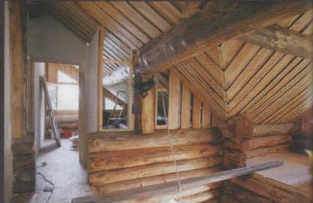
8. Ossature-bois classique entre poteaux de bois brut
