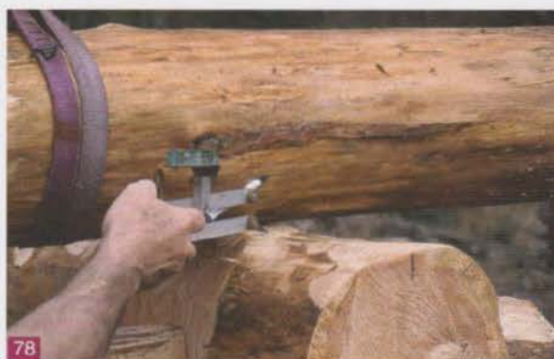
78 ... et tracés au compas et ajustés.
