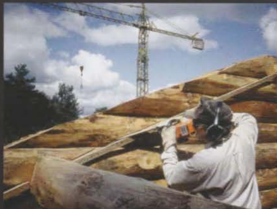
1. Sur toit à faible pente, découpe de la rainure d'encastrement du plafond
