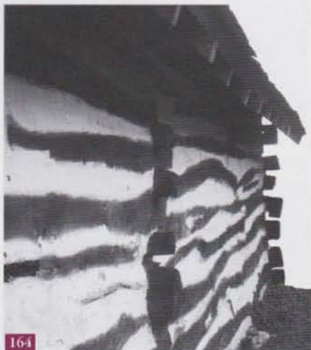
Maison en chêne empilé à Thionne (Allier) : sans doute des arbres trop tordus pour être utilisés ailleurs, jointés de terre et chaux
