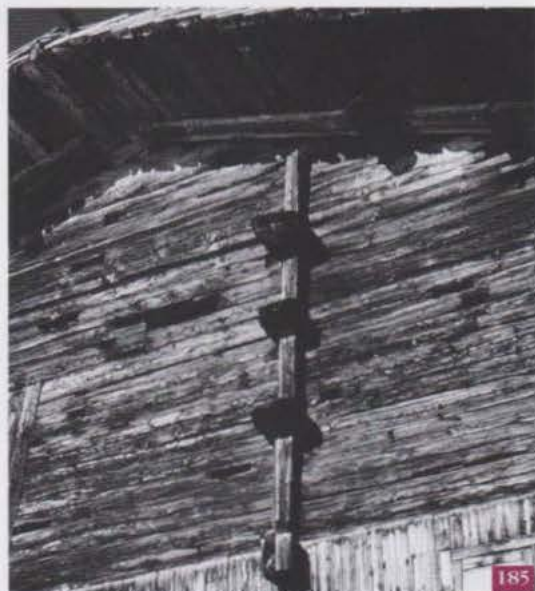
Pour retenir l'empilage des bois, une clef, caractéristique de l'architecture en bois de Haute-Savoie : ici sur un chalet du Grand Bornand
