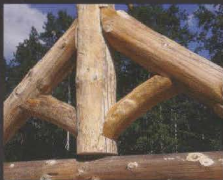
6. Assemblage bois rond sur bois rond tracé à l'aide du compas-traceur à niveaux
