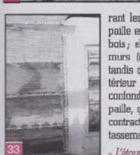
32 33 Joints de paille torsadés dans les Carpathes (région de Zakopane, Pologne)
