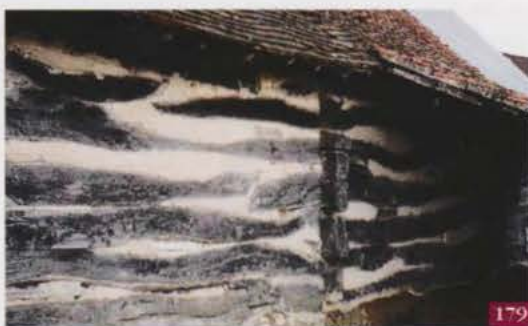
Empilage de poutres de chêne de toutes formes, jointées de chaux à Thionne (Allier).
